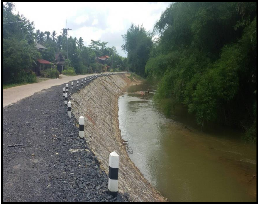
รูปที่ 49 : ก่อสร้างเสร็จ
