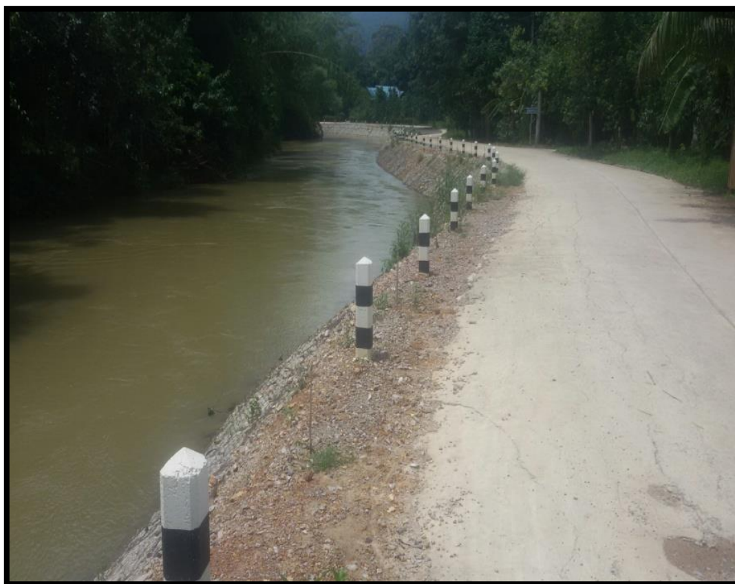
รูปที่ 51 : ก่อสร้างเสร็จ
