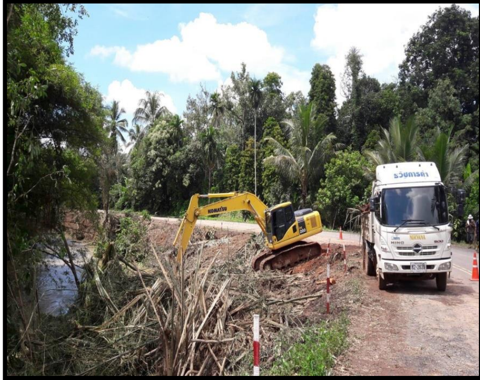
รูปที่ 39 : ระหว่างการก่อสร้าง
