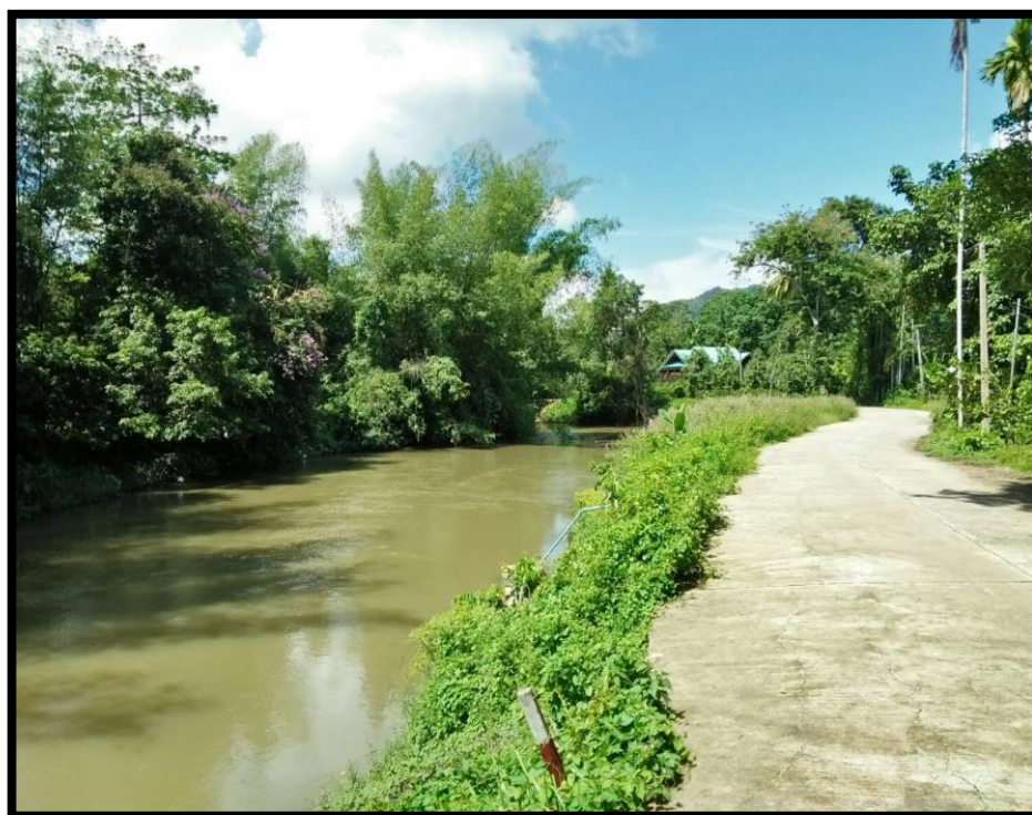
รูปที่ 36 : ก่อนการก่อสร้าง
