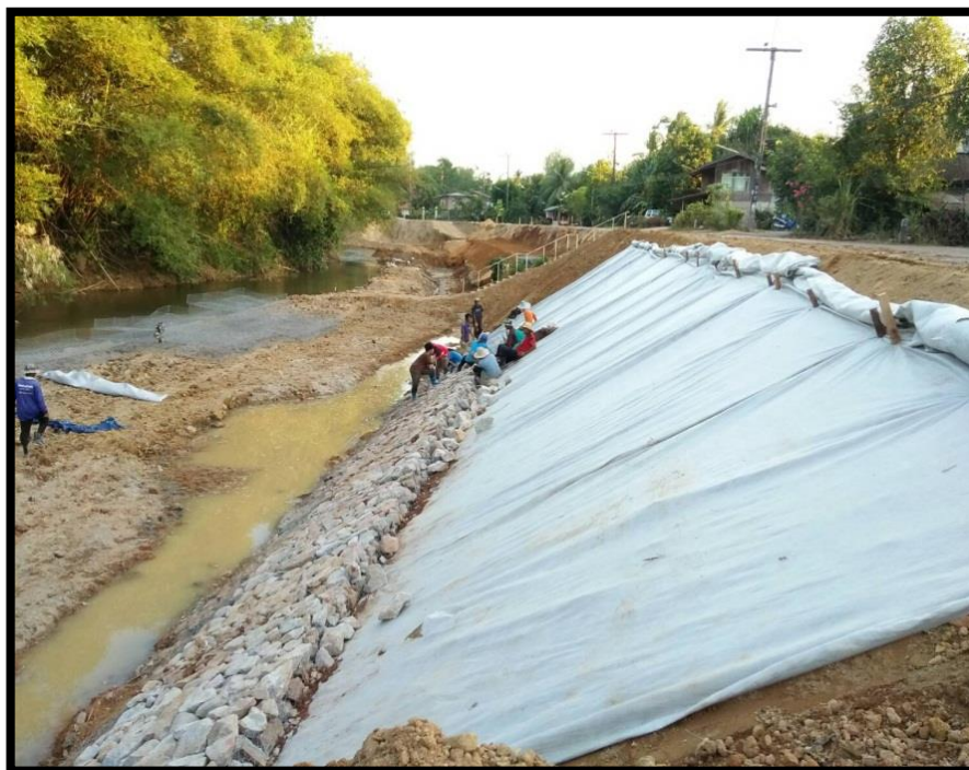
รูปที่ 41 : ระหว่างการก่อสร้าง
