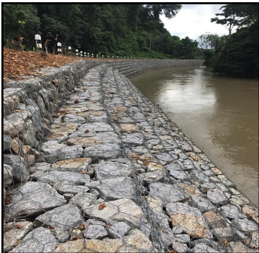
รูปที่ 45 : ก่อสร้างเสร็จ
