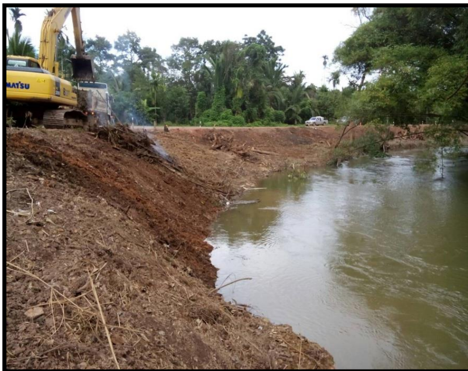
รูปที่ 37 : ระหว่างการก่อสร้าง
