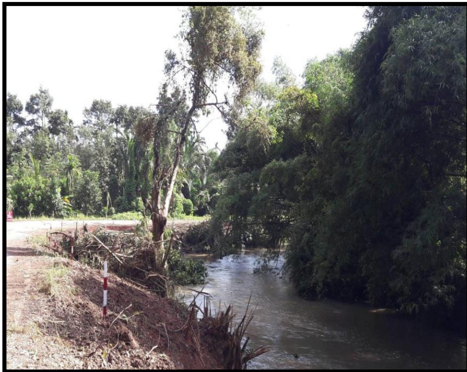
รูปที่ 40 : ระหว่างการก่อสร้าง
