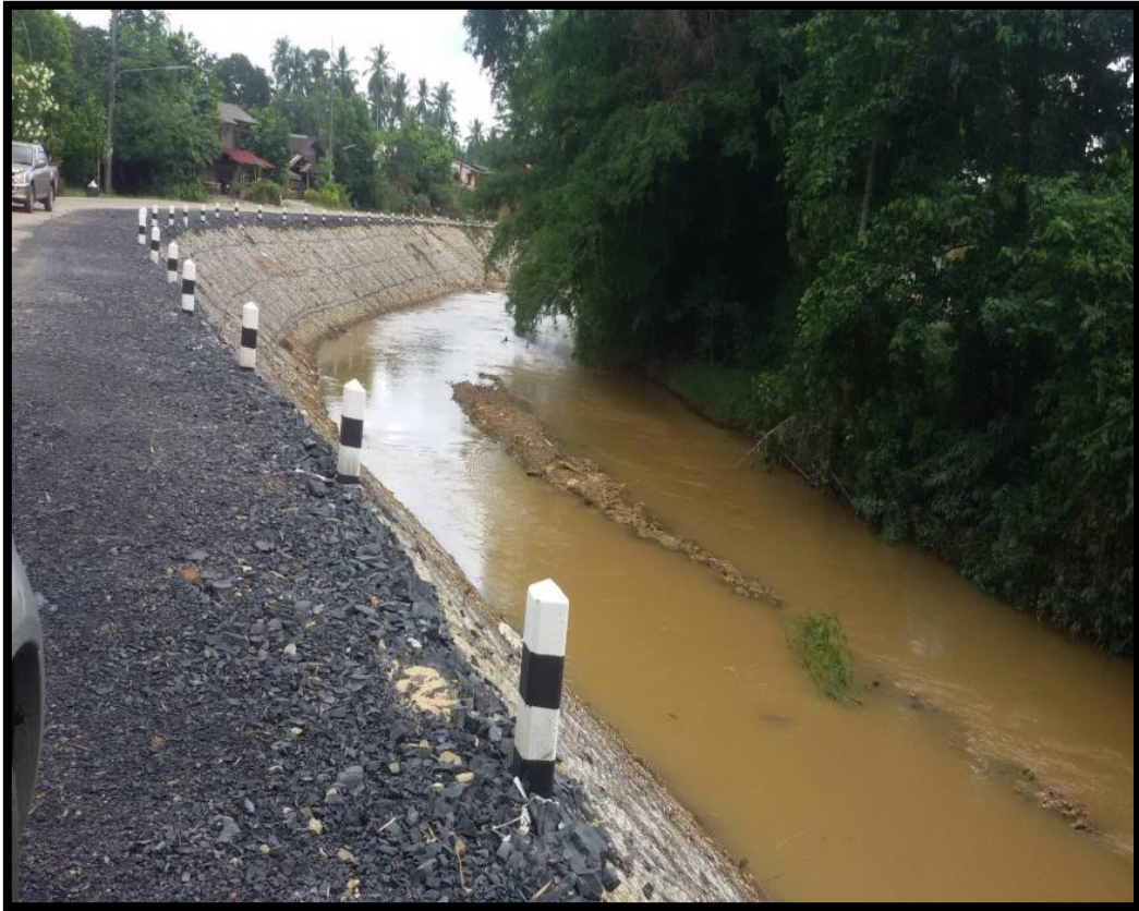
รูปที่ 50 : ก่อสร้างเสร็จ
