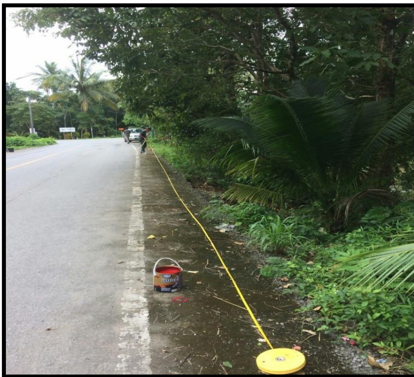
รูปที่ 31 : ก่อนการก่อสร้าง
