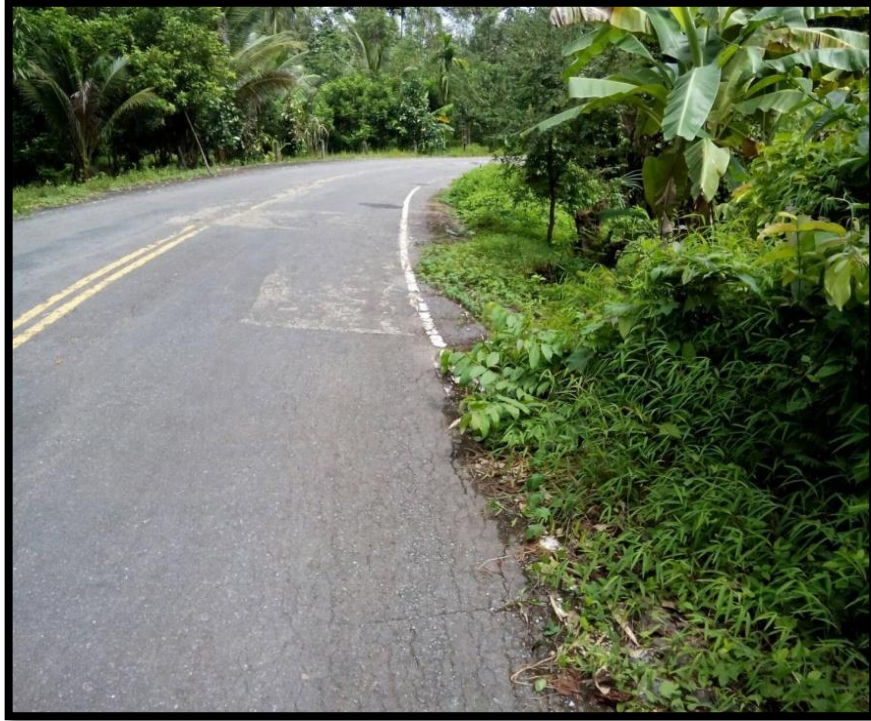
รูปที่ 29 : ก่อนการก่อสร้าง
