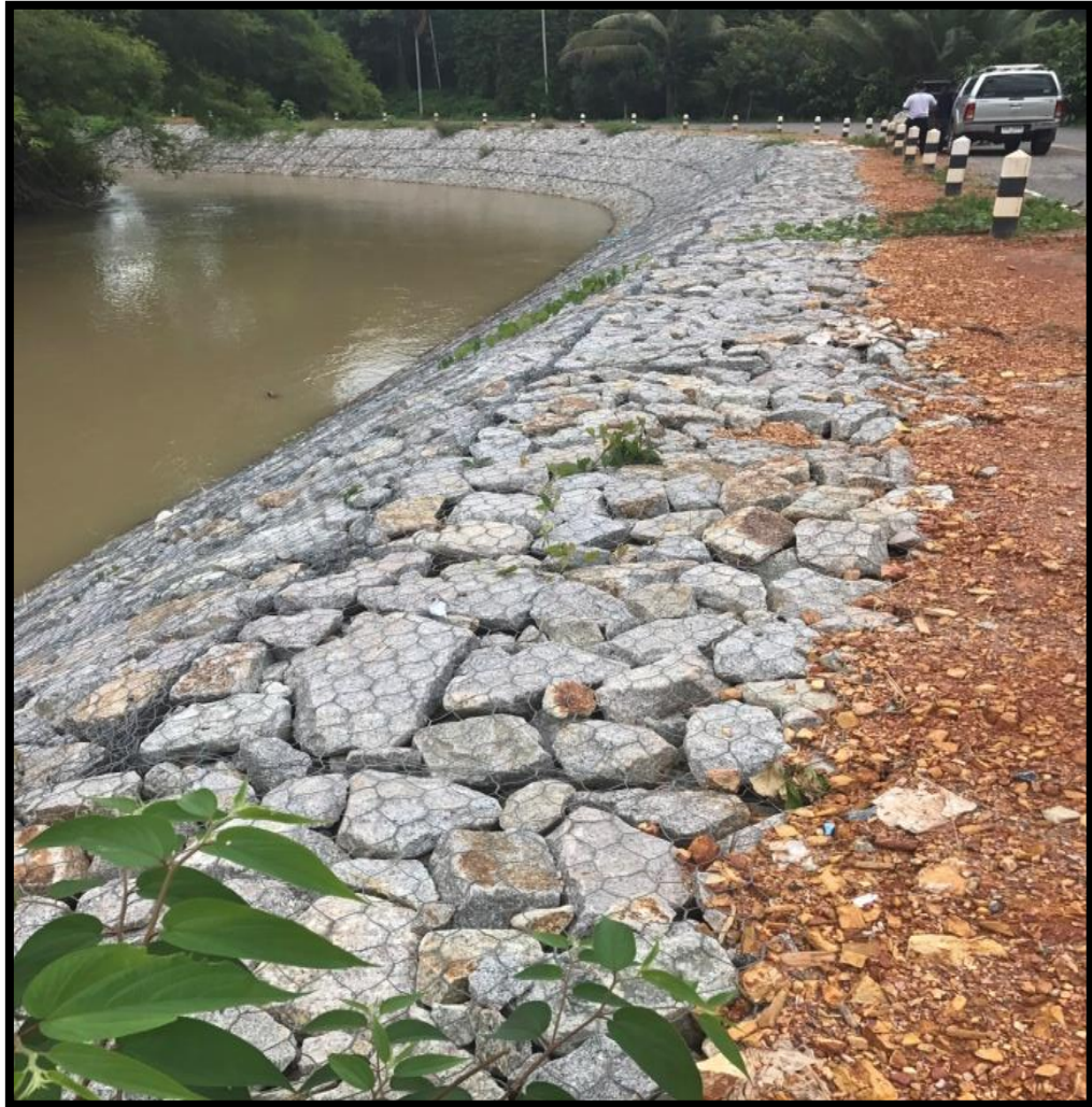
รูปที่ 47 : ก่อสร้างเสร็จ
