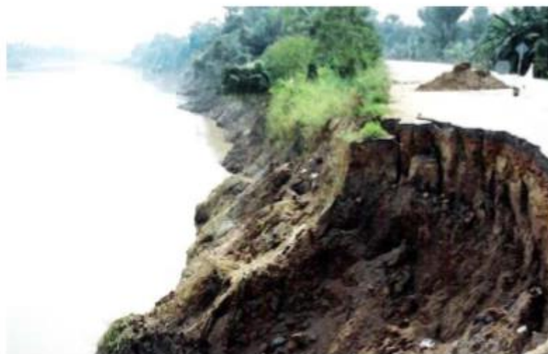
รูปที่ 6: แสดงตัวอย่างการพังทลายเนื่องจากกัดเซาะของตลิ่ง
