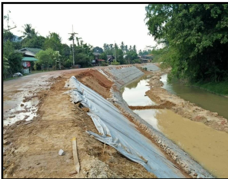
รูปที่ 42 : ระหว่างการก่อสร้าง
