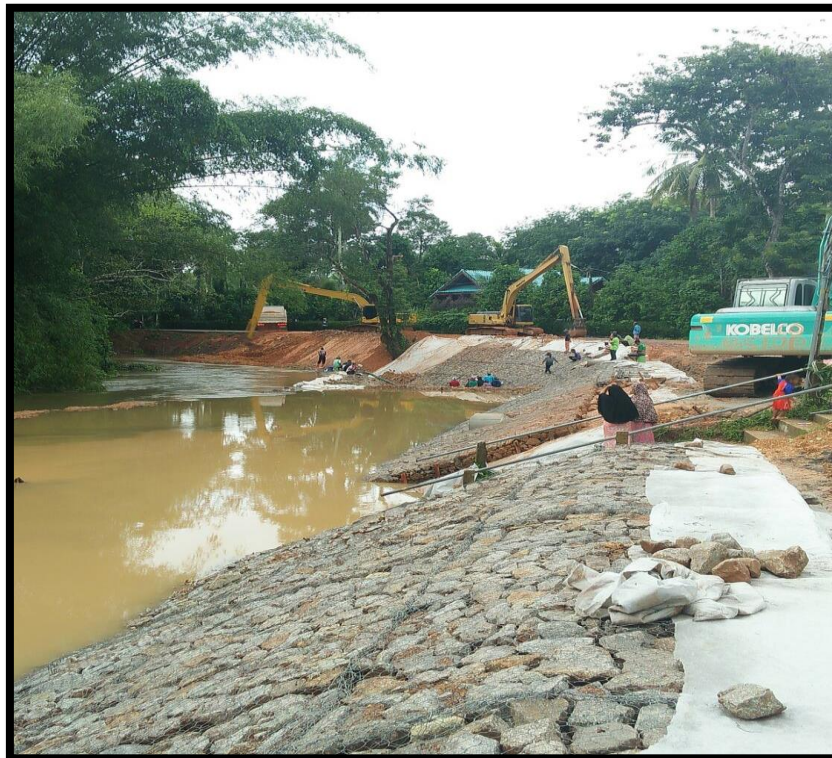
รูปที่ 44 : ระหว่างการก่อสร้าง
