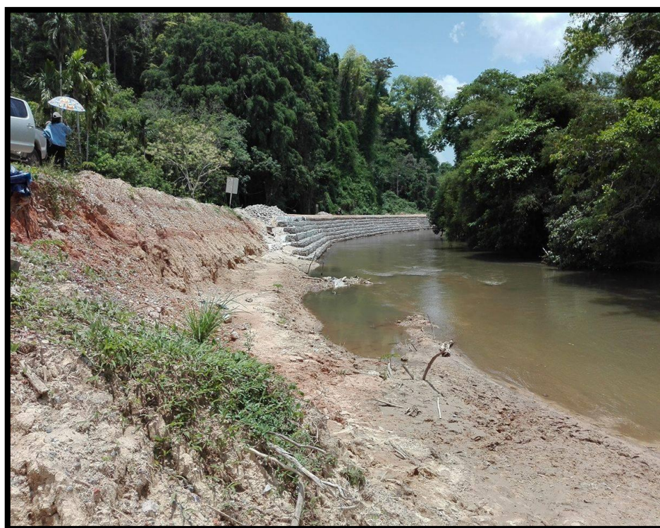
รูปที่ 38 : ระหว่างการก่อสร้าง
