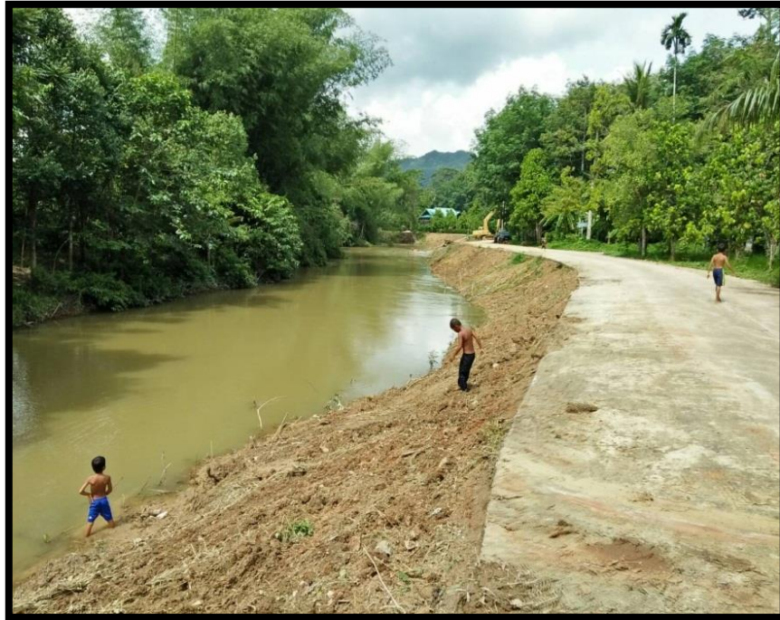
รูปที่ 43 : ระหว่างการก่อสร้าง
