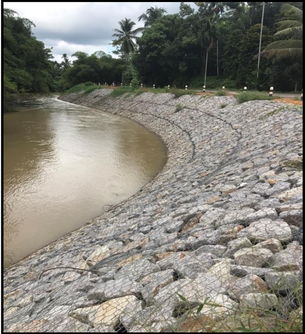
รูปที่ 48 : ก่อสร้างเสร็จ
