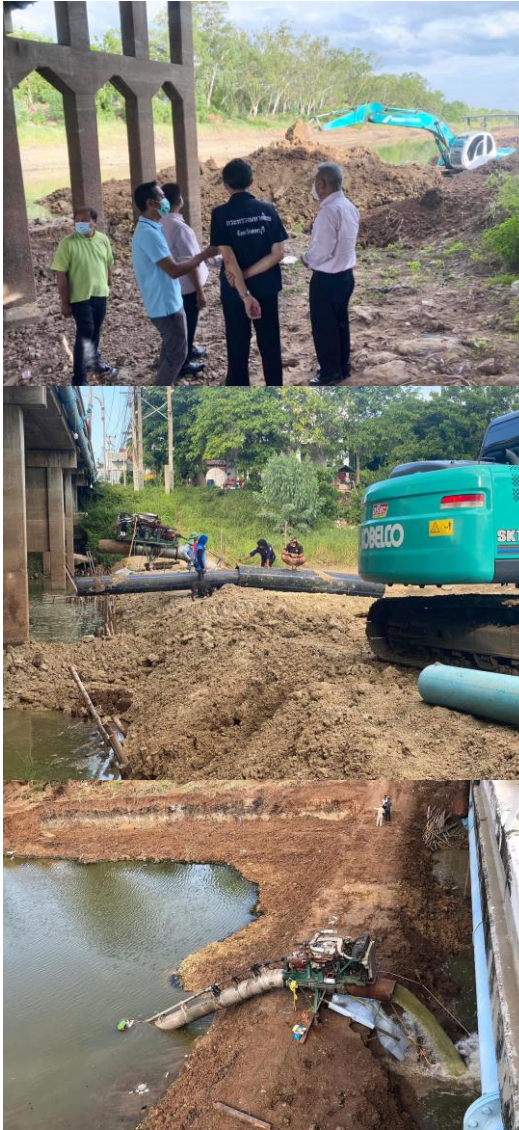
รูปที่ 4.6-11 ก่อสร้างทำทบ คลองขียนาท-ป่าสัก กม.98+000 บริเวณสะพาน 7 ช่วยเหลือน้ำดิบของการประปาส่วนภูมิภาคสาขาสะพาน 7 ต.บ้านกล้วย อ.บ้านหมี่ จ.ลพบุรี
