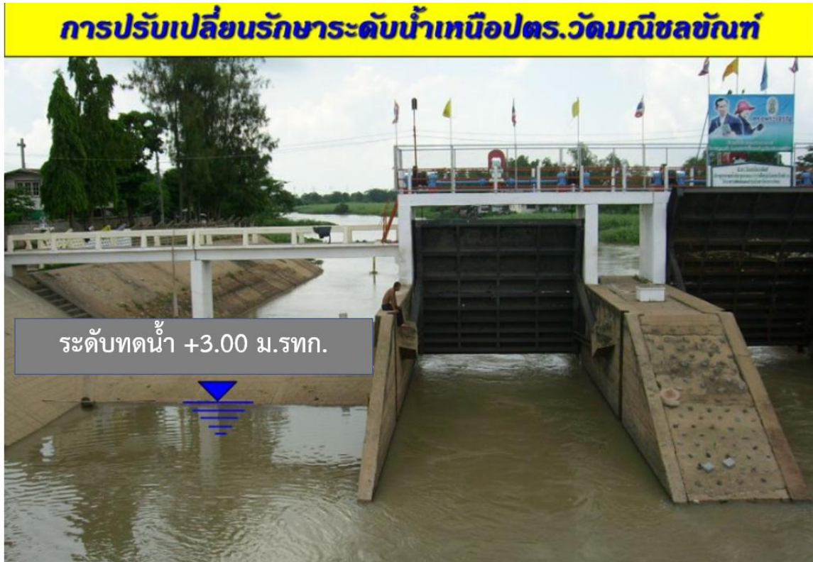
รูปที่ 4.6-6 ประตูระบายน้ำวัดมณีชลขันธ์ ที่ระดับน้ำ +3.00 ม.รทก. ระดับสันฝาย +7.00 ม.รทก.
