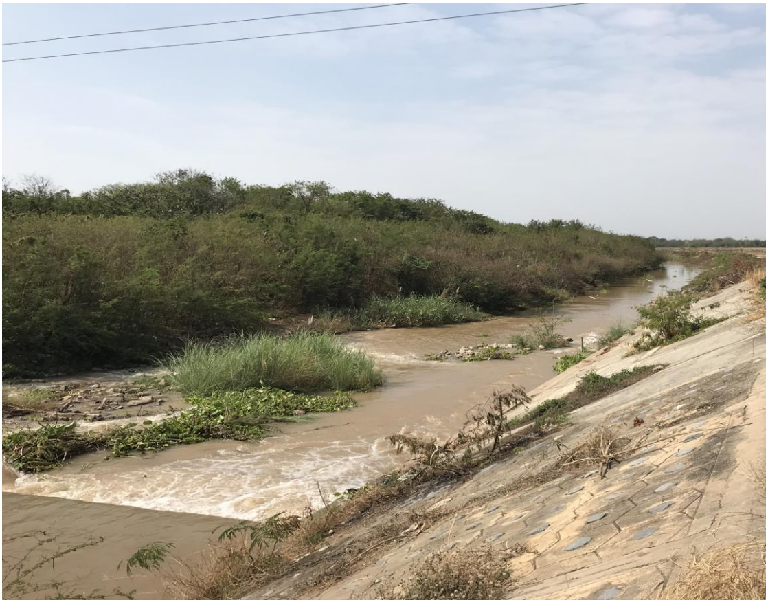
รูปที่ 5-12 การดำเนินการระบายน้ำทางอาคาร Waste way เพื่อแก้ไขปัญหาน้ำเน่าเสียในแม่น้ำลพบุรี
