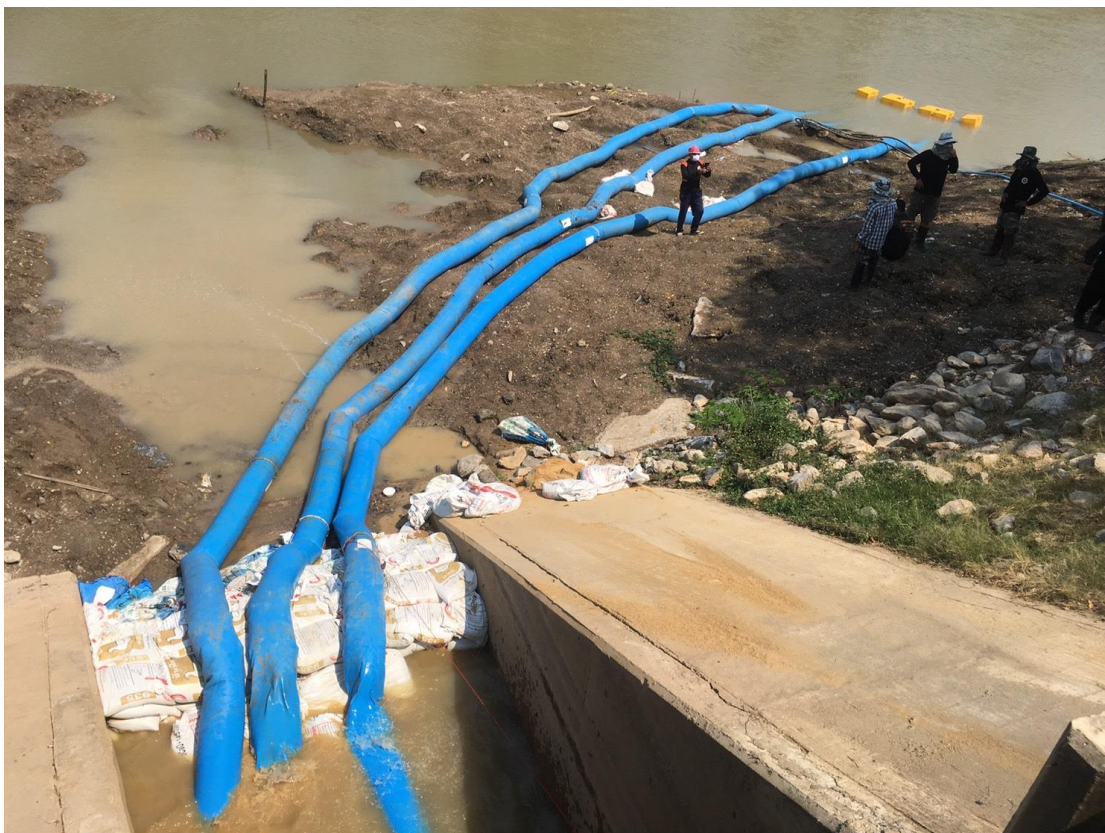
รูปที่ 5-8 การติดตั้งเครื่องสูบน้ำเคลื่อนที่บริเวณปากคลองส่งน้ำ 21 ชาวช่วยเหลือพื้นที่เพาะปลูกกระถ่อน
