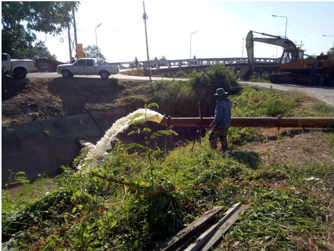
รูปที่ 5-9 การติดตั้งเครื่องสูบน้ำเคลื่อนที่สูบน้ำจากแม่น้ำลพบุรี ช่วยเหลือพื้นที่เพาะปลูกกระถอน
