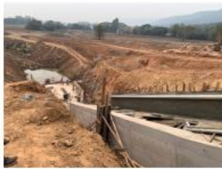
รูปภาพระหว่างก่อสร้างวางไม้แบบ Stilling Basin และ ลูกปูนสำหรับทดสอบ
