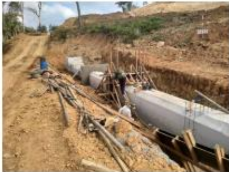
รูปภาพระหว่างก่อสร้างวางไม้แบบ Stilling Basin และ ลูกปูนสำหรับทดสอบ
