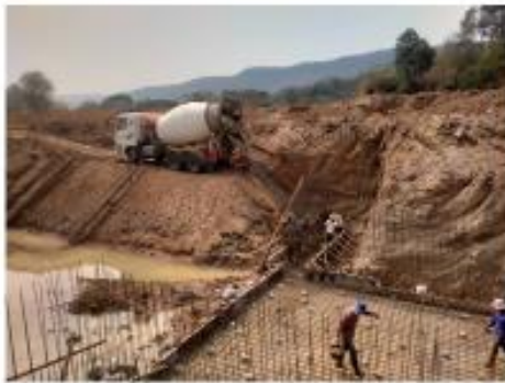
รูปภาพระหว่างก่อสร้างวางไม้แบบ Stilling Basin และ ลูกปูนสำหรับทดสอบ
